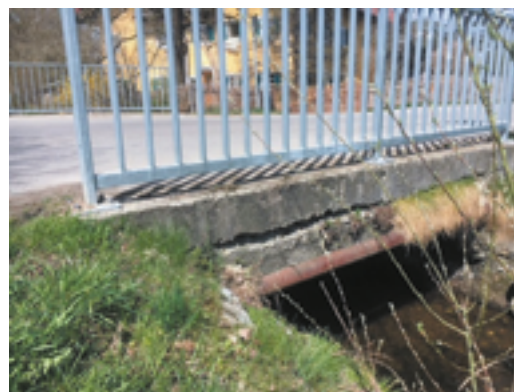
Brücke Kempfenhauser Straße
